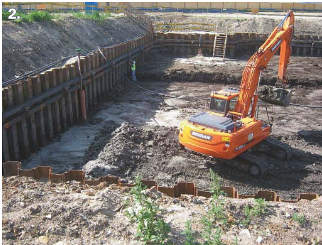
Fot. 2. Głębianie wykopu do poziomu wymiany gruntu
