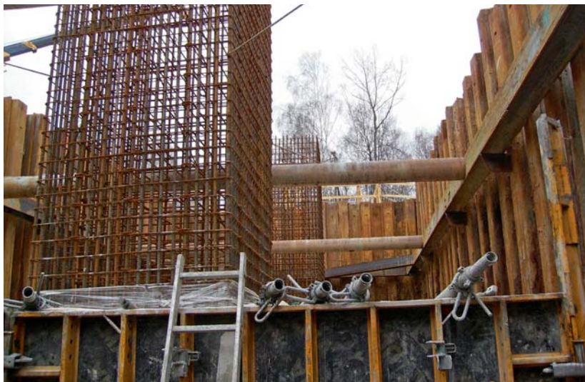
Fot. 2. | Widok z dna wykopu na ramę rozparcia
