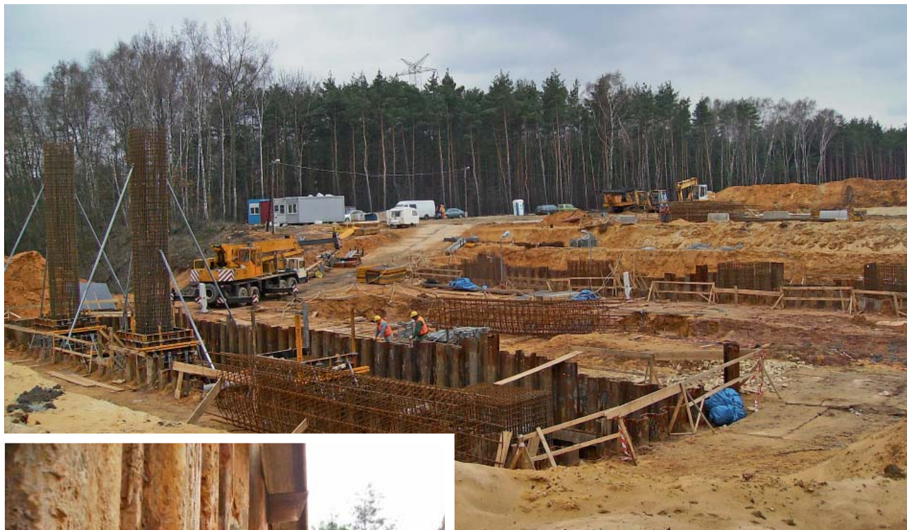
Fot. 3. | Obiekt MA-421 – widok na plac budowy
