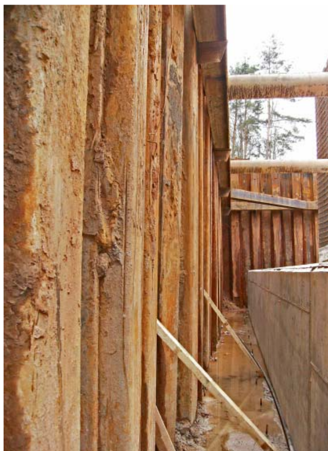
Fot. 4. | Widok z dna wykopu na krawędź fundamentu i ściankę z grodzic.
