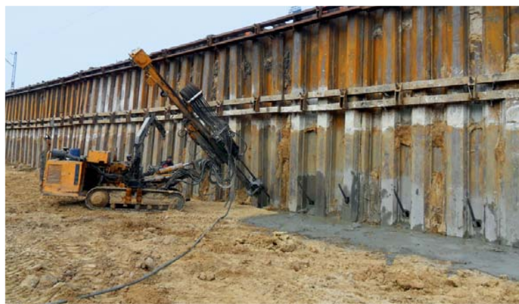
Fot. 3. | Wykonanie kotwienia ścianki szczelnej
