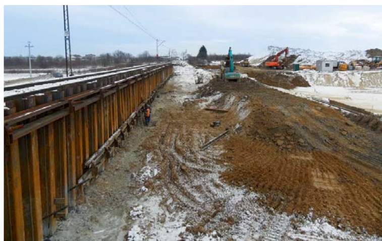
Fot. 4. | Montaż kleszczy stalowych o profilu 2HEB220
