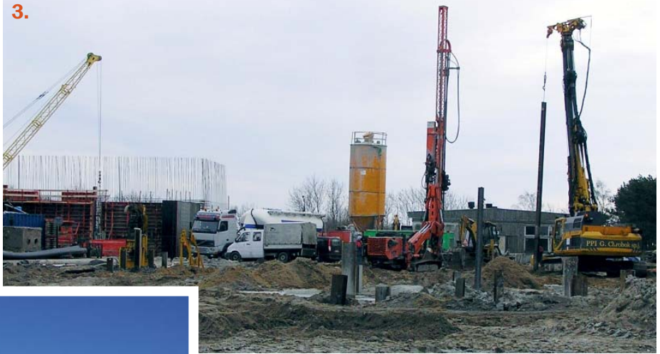
Fot. 3. Wykonanie pali jet-grouting, montaż zbrojenia
