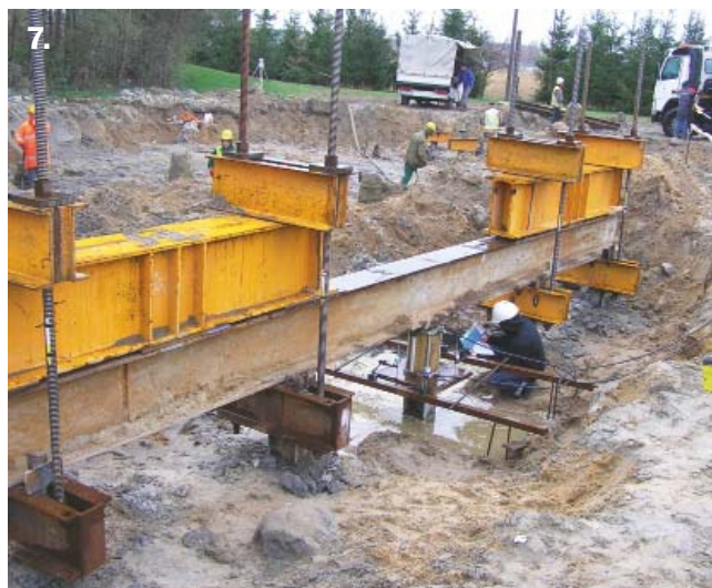
Fot. 7. Próbné obciążenie pali
