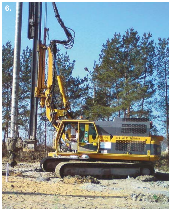
Fot. 6. Zastosowanie świda przemieszczeniowego
