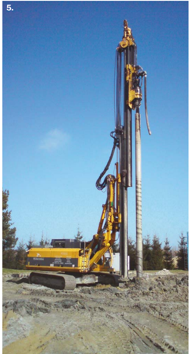
Fot. 5. W trakcie realizacji pali przemieszczeniowych
