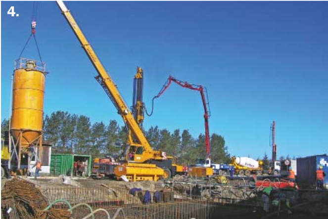
Fot. 3. Wykonanie pali jet-grouting, montaż zbrojenia
