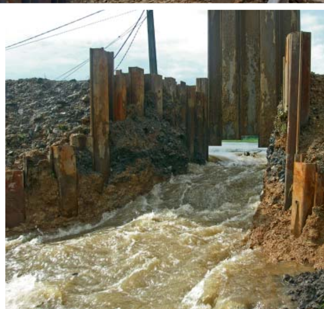
Fot. 2. | Bieruń – tymczasowa śluza spustowa zabezpieczona ścianką z grodzic
