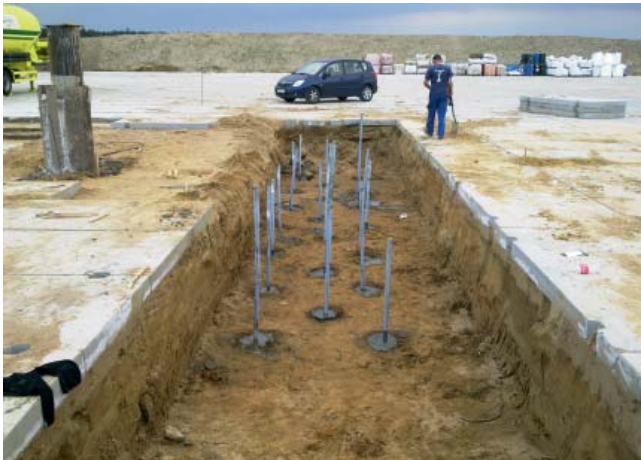
Fot. 6. | Efekt końcowy z nadwyżką żerdzi do odcięcia
