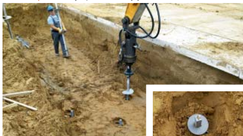
Fot. 3. | Instalacja sekcji ↑ czołowej mikropala
