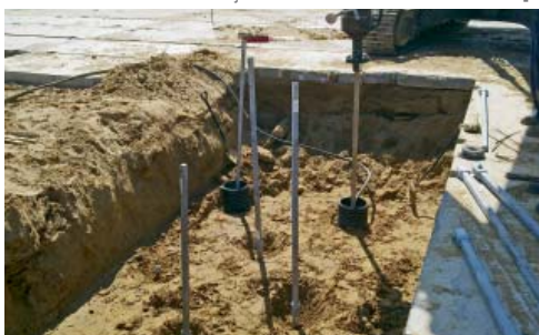
Fot. 5. | Wkręcanie poszczególnych mikropali
