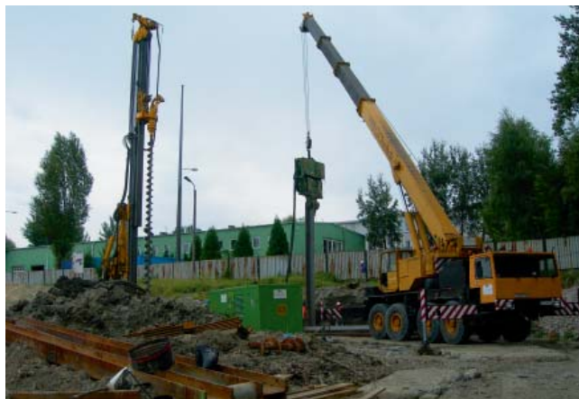
Fot. 4. | Trudne warunki wymagały podwiercania gruntu
